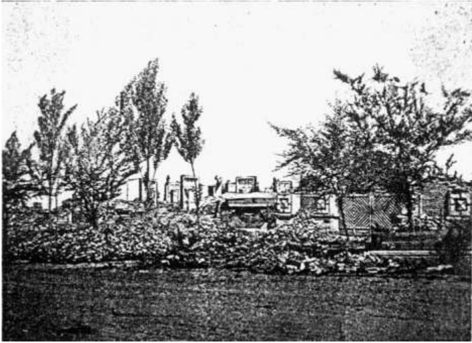
Рис. 2.1.15. От каменного дома остались только деревянные рамы
