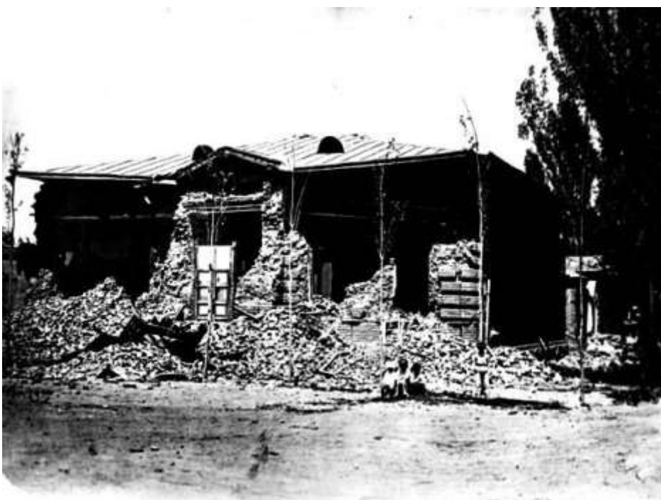
Рис. 2.1.6. Здание хромофотографии до и после землетрясения
