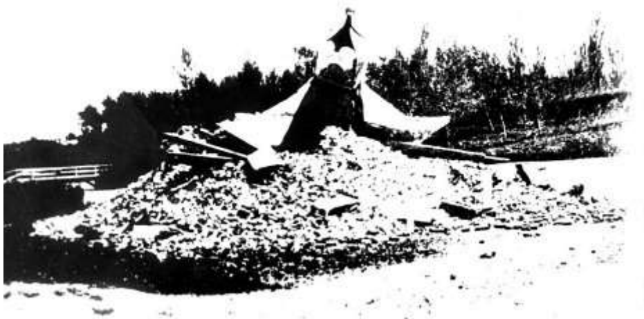
Рис. 2.1.17. Место у водосвятия Казенного сада, разрушенное до основания
