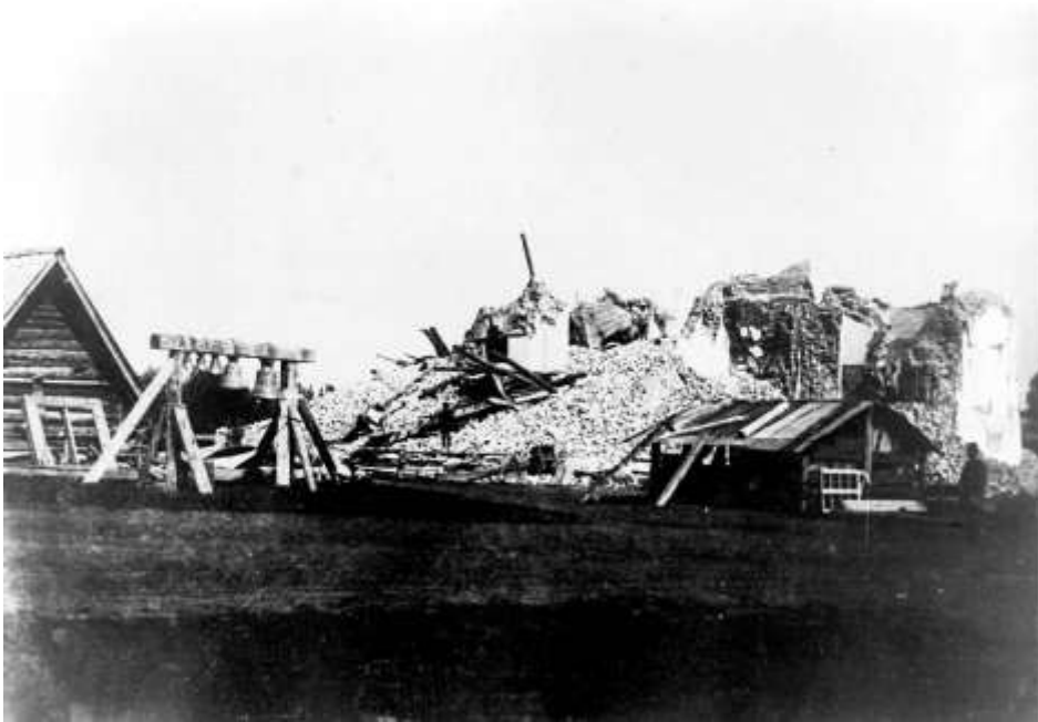
Рис. 2.1.16. Покровская церковь после землетрясения
