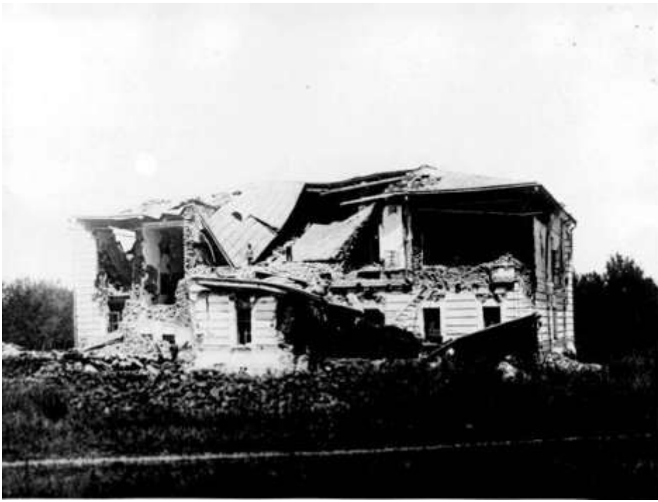
Рис. 2.1.10. Здание женской гимназии, обрушившееся после землетрясения
