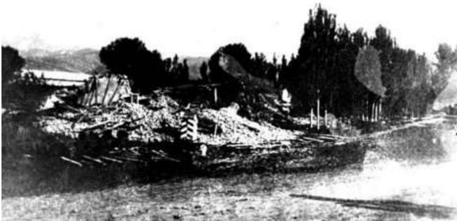
Рис. 2.1.14. Военные лагеря, почти полностью разрушенные во время землетрясения
