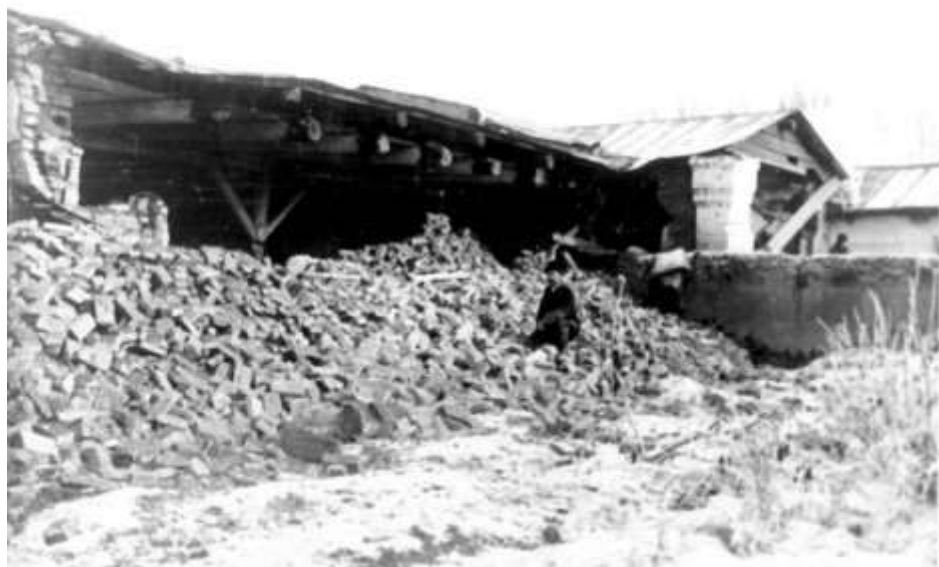
Рис. 2.3.3б. Склады после землетрясения
