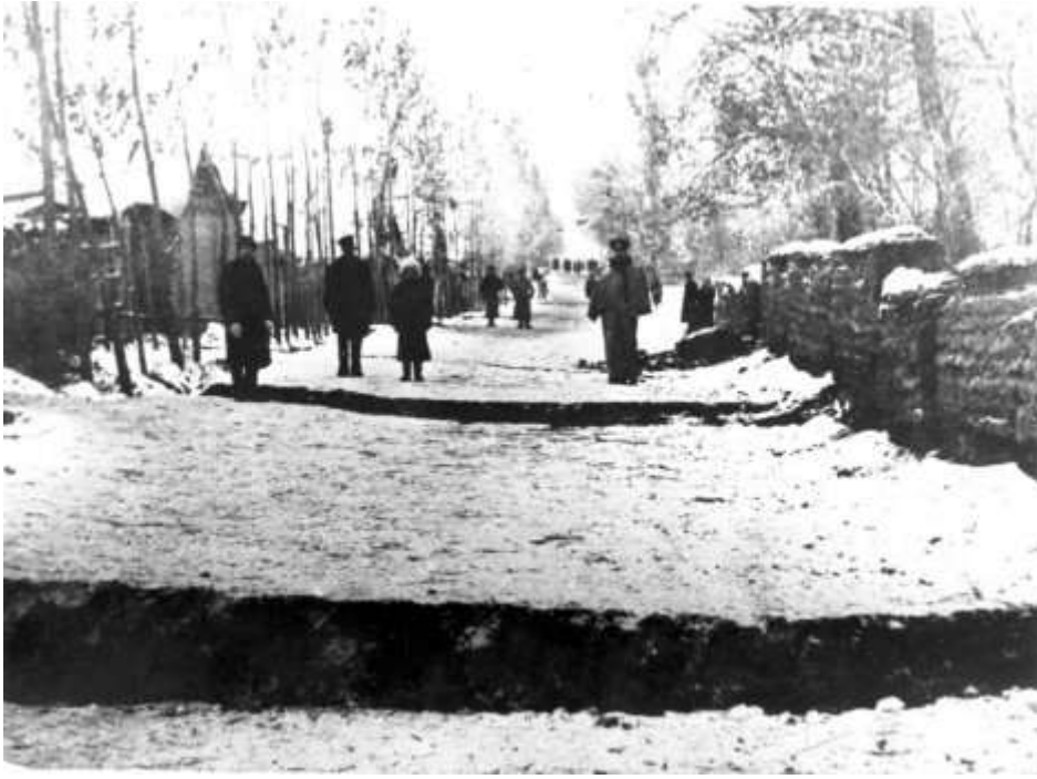
Рис. 2.3.11а, б. Широкие трещины в грунте
