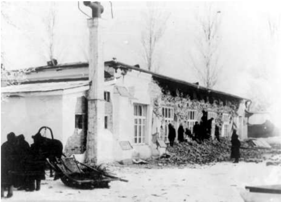
Рис. 2.3.4г. Общий вид стены поврежденного кирпичного здания
