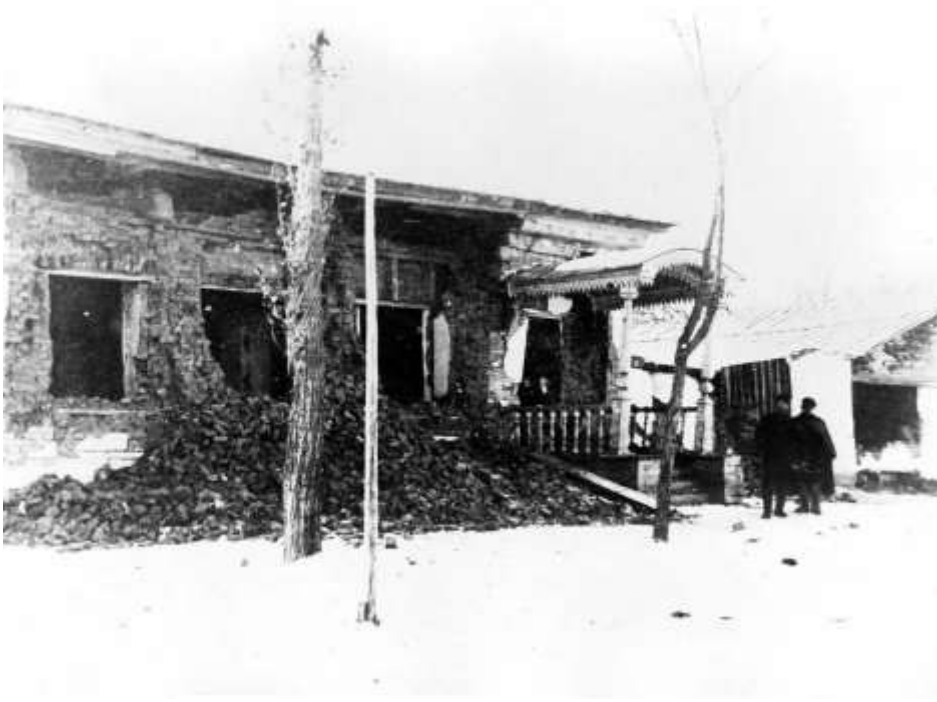
Рис. 2.3.4б. Обрушение наружной стены жилого дома
