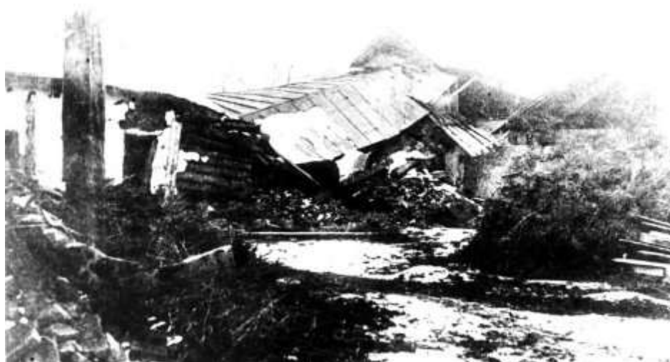
Рис. 2.3.3а. Обрушившийся жилой дом
