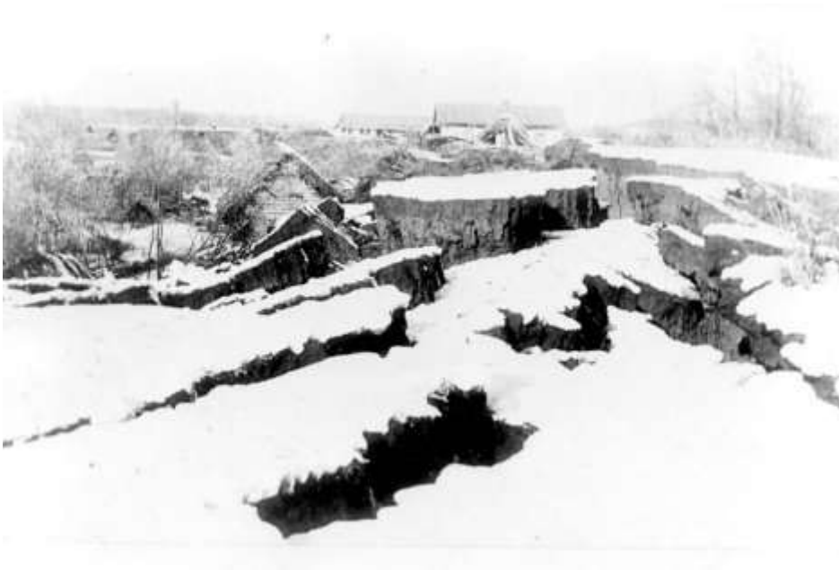
Рис. 2.3.8. Деформации земной поверхности в результате землетрясения (северная окраина города)
