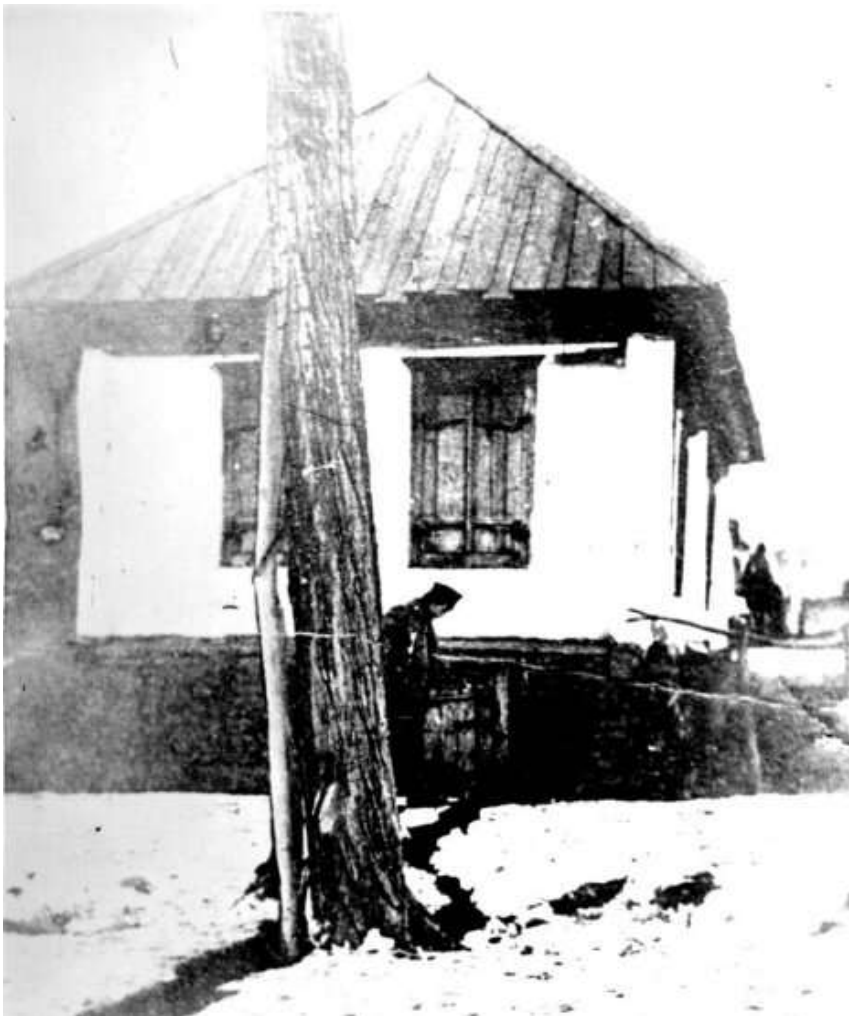
Рис. 2.3.12. Трещина в грунте, уходящая под фундамент жилого деревянного дома
