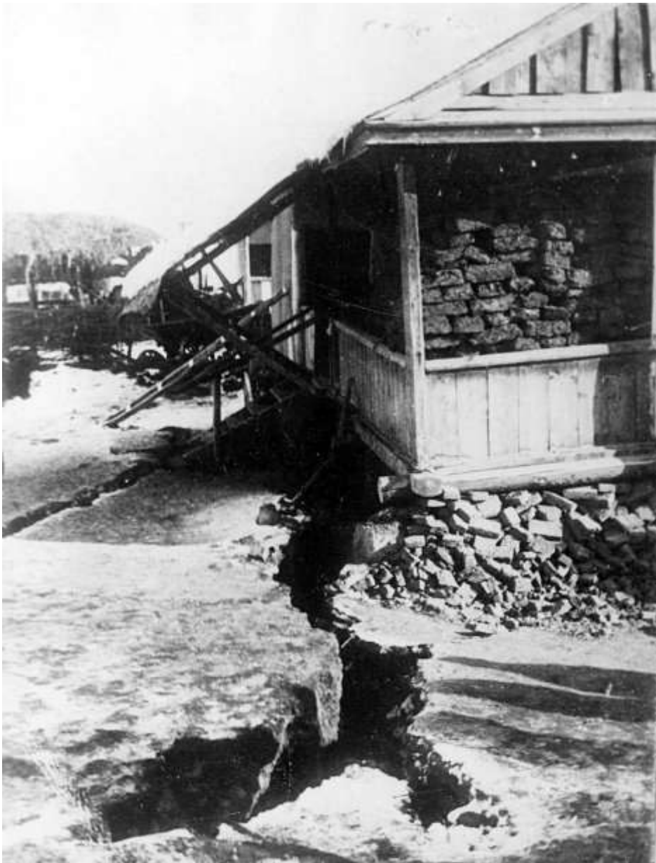
Рис. 2.3.6. Деревянное здание выдержало сейсмические сотрясения, но против разрыва грунта выстоять не смогло
