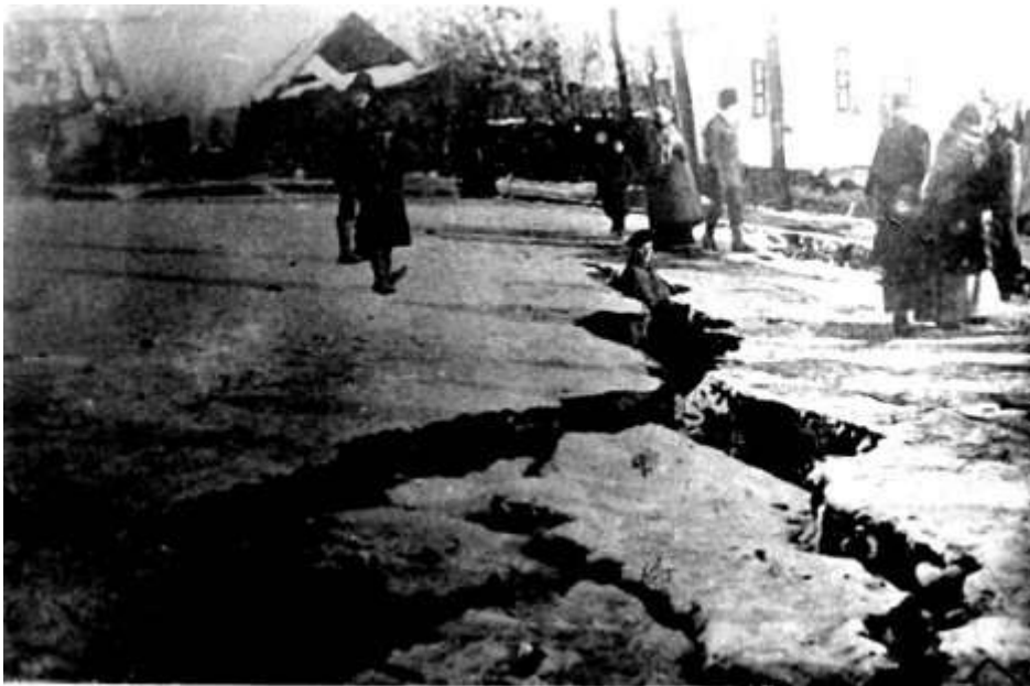
Рис. 2.3.9. Впечатляющее зрелище представляет собой человек в образовавшейся трещине шириной до 1 м
