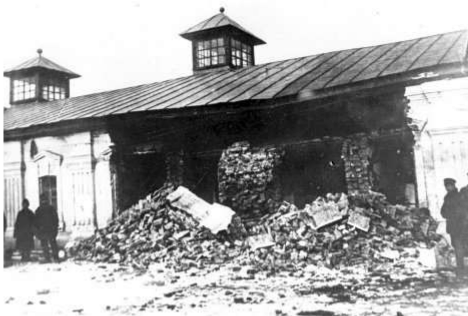
Рис. 2.3.4а. Баня Жиленкова. Обрушение части здания
